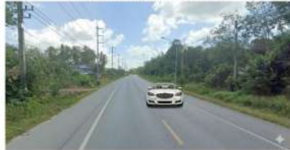
ลักษณะสายทางหลังดำเนินการ
