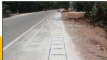
ออกแบบวางระบายน้ำด้านข้างในช่วงที่มีผลต่อการไหลของน้ำ
