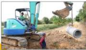
ต่อเชื่อมและขยายท่อระบายน้ำเดิมให้มีขนาดเหมาะสม
