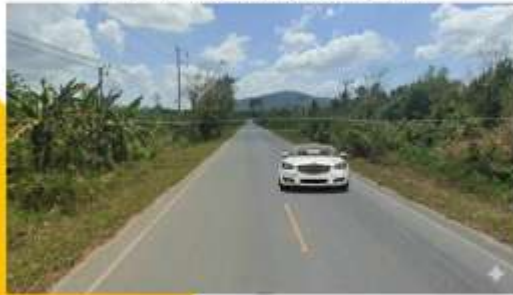
ลักษณะสายทางก่อนดำเนินการ
